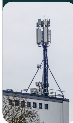
Edificios y/o sus Azoteas
