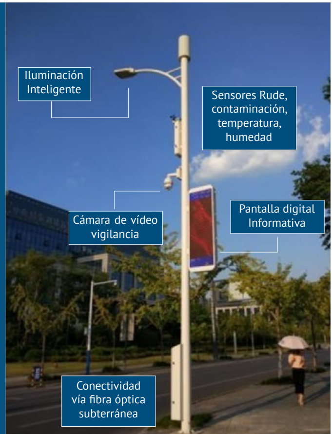
Figura 1. Infraestructura tipo Multiuso (Smart Pole)
